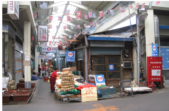
[사진 20] 비가림막 공사를 하지않은 9동상가
